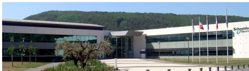
Photographie du site Schneider Electric d'Eybens
